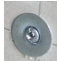
**Sistema di Fissaggio con Tassello in acciaio di 3 tipi:
